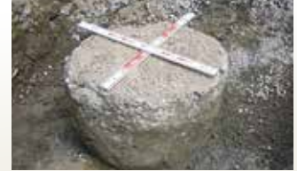
SCP杭の打設状況
