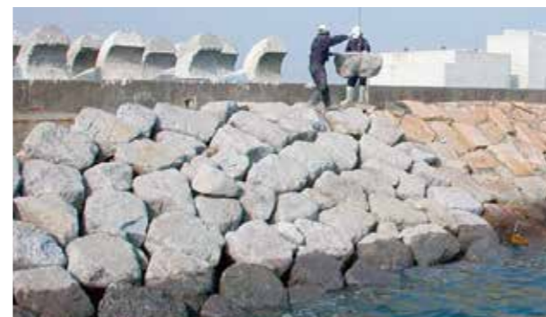
港湾修繕工事
