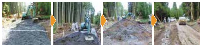
ジオタイザー敷均し 重機にてジオタイザーを所要量敷き均す
