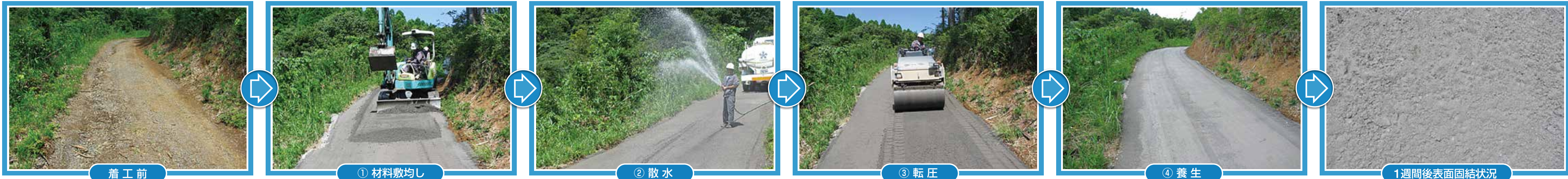
図2：施工フロー(林道の舗装例)
