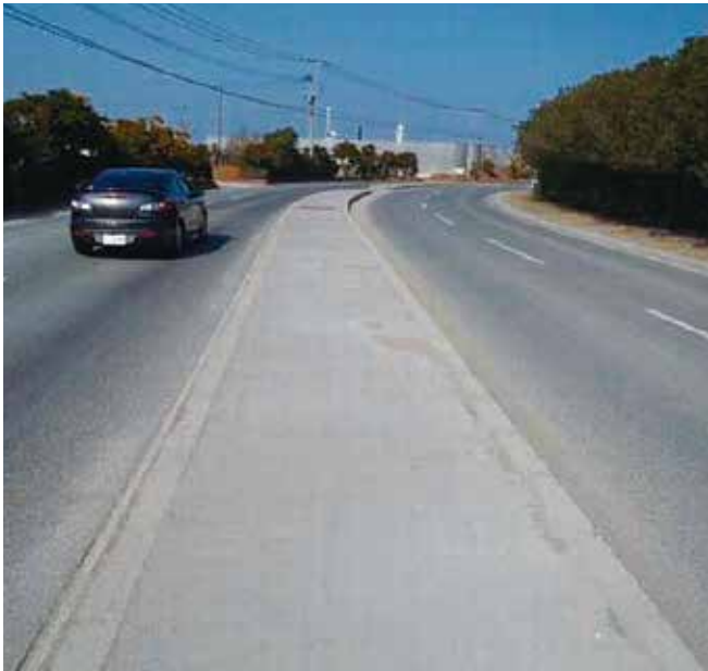
写真 3 : 中央分離帯防草対策
