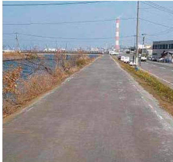
写真 4 : 河川護岸天端管理道路
