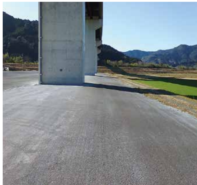
写真 8 : 高架下防草対策
