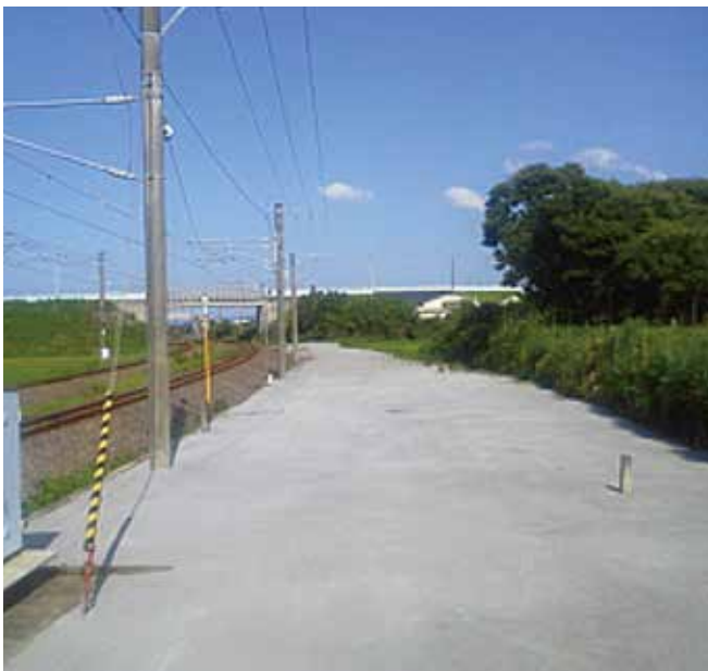
写真 5 : 線路脇管理用地防草対策
