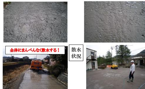
注) 転圧後の再整形は極力行わないでください。再整形により粗骨材が表面に現れ、仕上がりが荒くなり耐久性が低下します。
