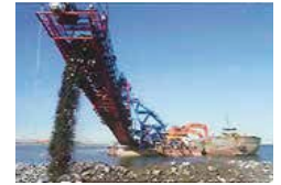
作業船による掘土状況
