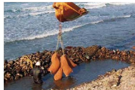
埋設実験(ビバリーユニット)
