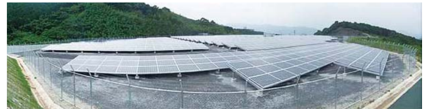
ソーラー発電所防草対策用施工例
