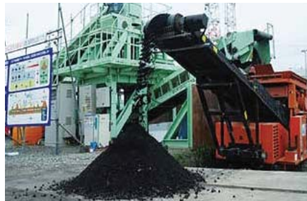
分別・改良された土
