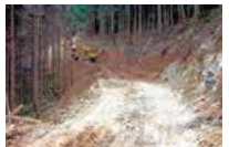
林道(作業道)施工前
