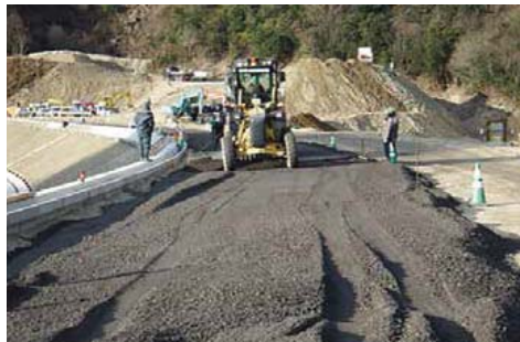
和歌山峠道路(路盤材)
