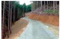
林道(作業道)施工後
