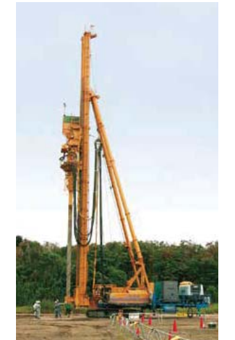
地盤改良施工状況(SAVEコンポーザー)
