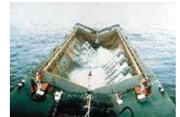
底開/バージ船での投入状況
